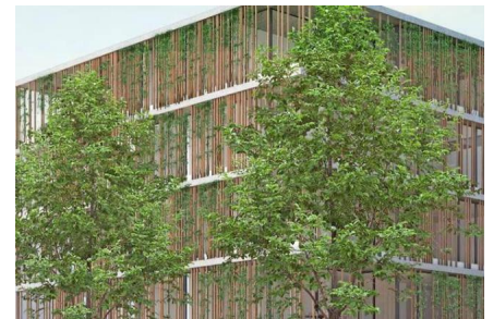
Vertikale Holzstruktur: Hinter den begrünten Fassaden der Wohnungen ist Platz für ein Gärtchen. Im Untergeschoss das mit Biogas betriebene Blockheizkraftwerk.
