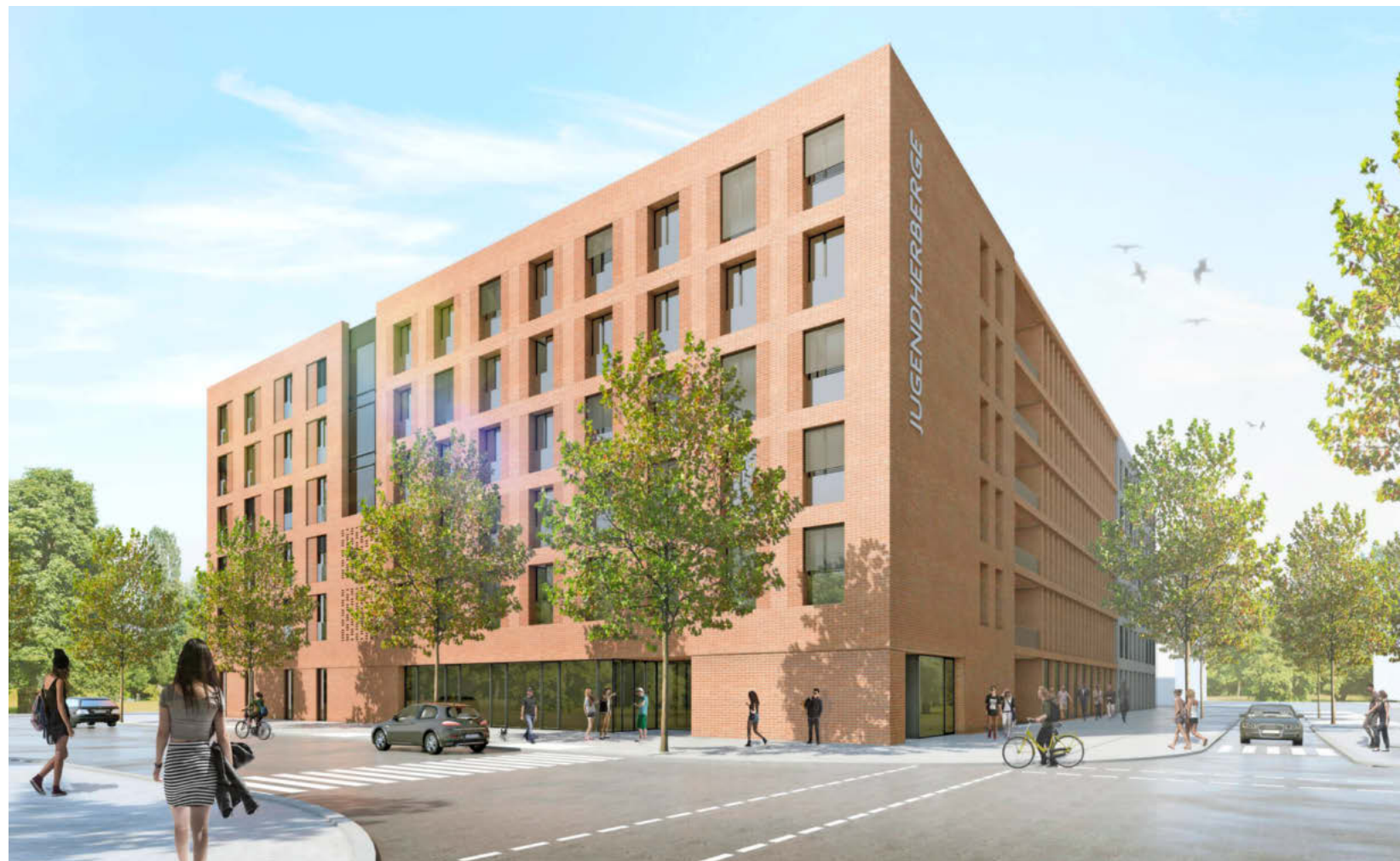
Hier ist ab Sommer 2018 die Jugend der Welt zu Gast. Eine markante Fassade aus roten Backsteinen prägt den den Neubau.
