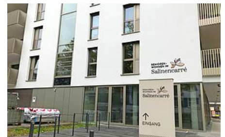
Noch steht vereinzelt Baumaterial vor dem Salinencarré. Bis Jahresende sollen alle Arbeiten abgeschlossen sein. Foto: Elfi Hofmann
