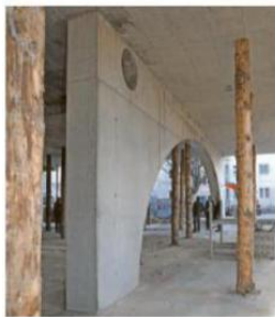
Dieser Rundbogen überspannt den Kinosaal im Keller des Marra-Hauses.
